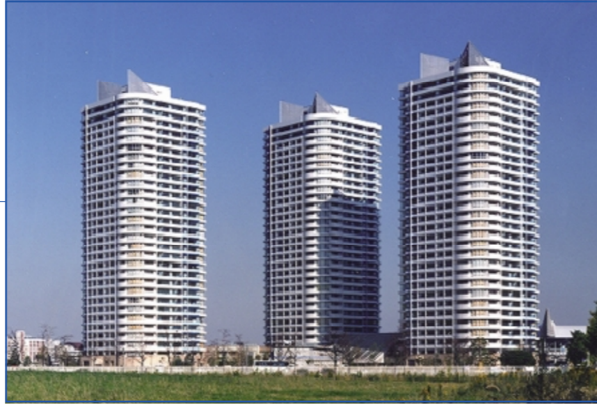
MMTOWERS 神奈川県横浜市西区
