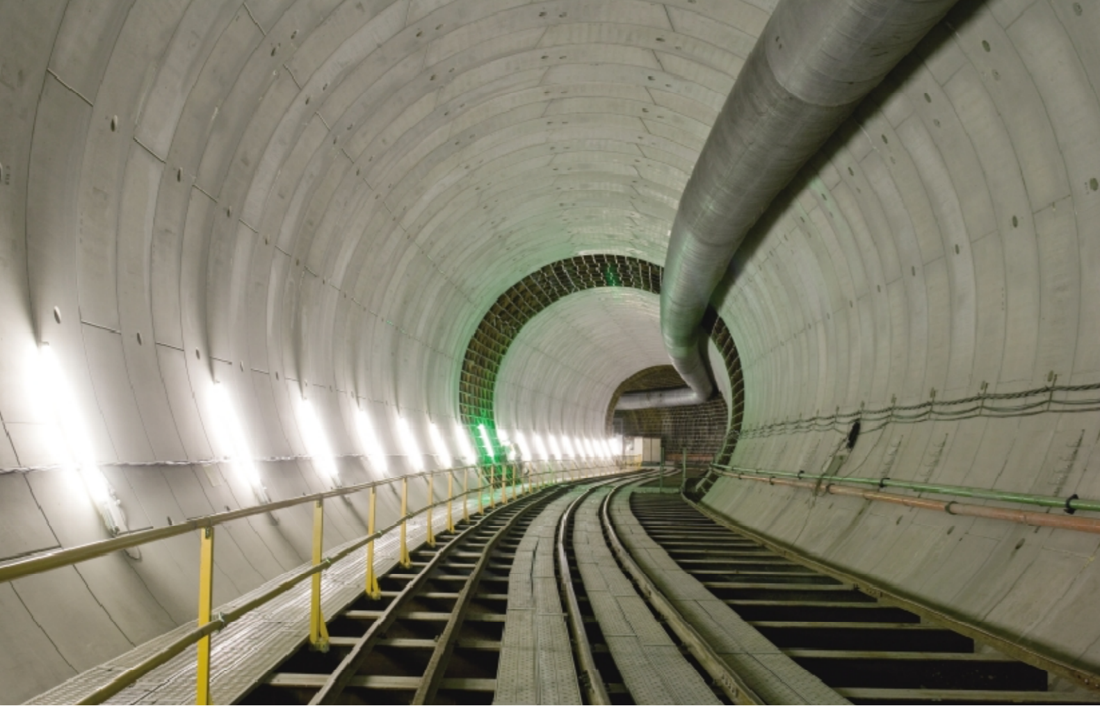
下水道事業団 東京都勝島ポンプ所流入管渠工事 外径：10,100 桁高：400 セグメント幅：1,000 分割数：8 スライドコッター、クイックジョイント採用
