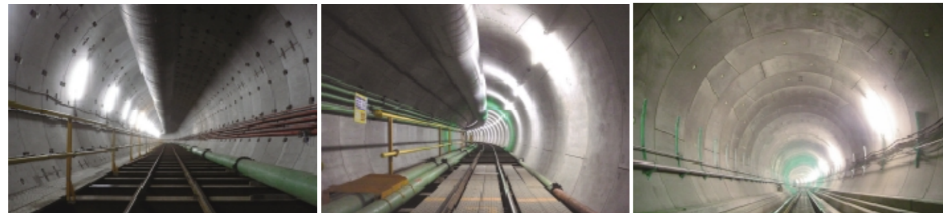
川崎市建設局 大師河原貯留管その2工事 外径：6,000 桁高：250 セグメント幅：1,200 分割数：6
