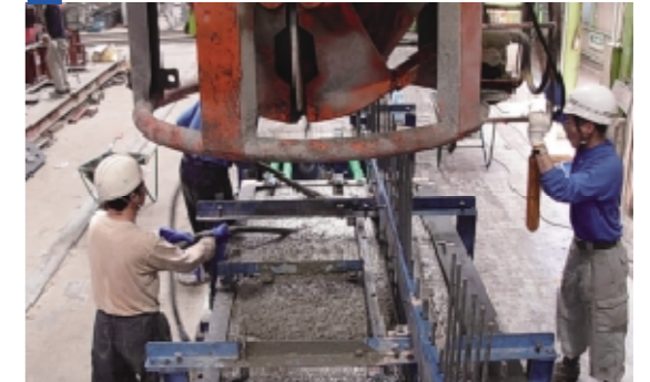
4 コンクリート打設
