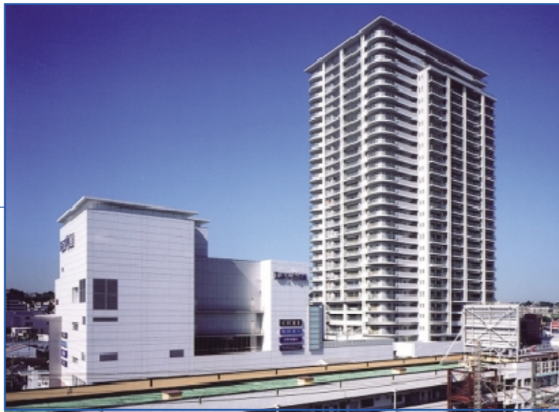
新杉田駅前地区市街地 再開発ビル 神奈川県横浜市磯子区
