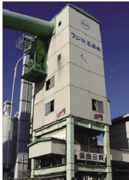
■第1バッチャープラント 練り混ぜ設備 二軸型強制練ミキサー1.7m 3 1基
