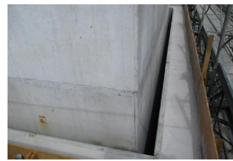
鞘管躯体コンクリート打設完了
