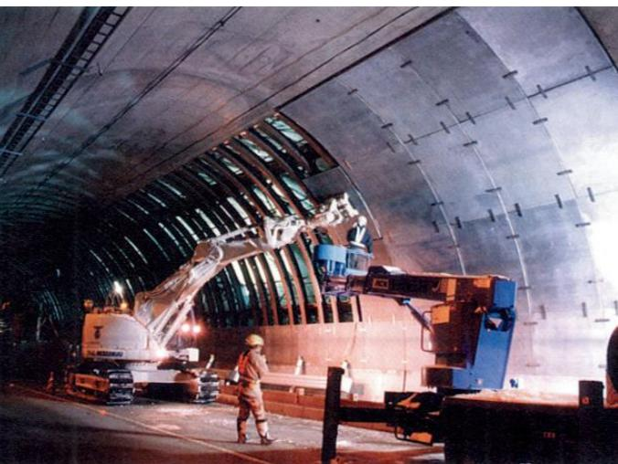
トンネル接合部覆工施工事例
