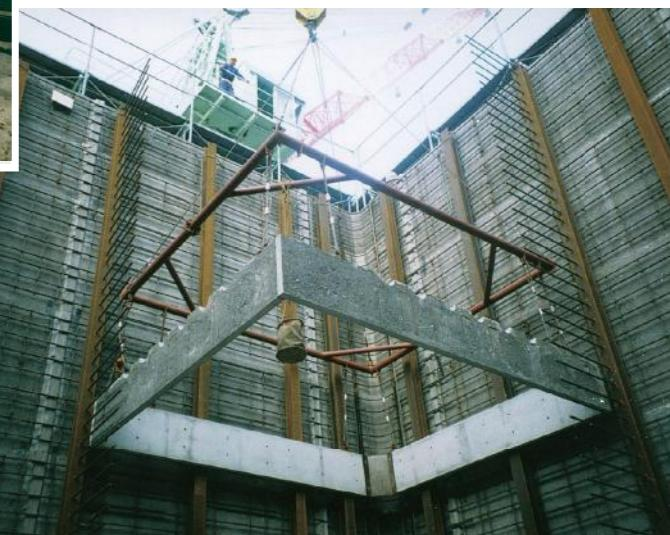
内部隔壁 RC 板の建込状況
