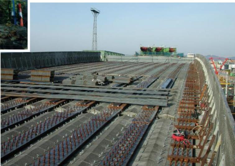
合成主桁間底版型枠設置状況
