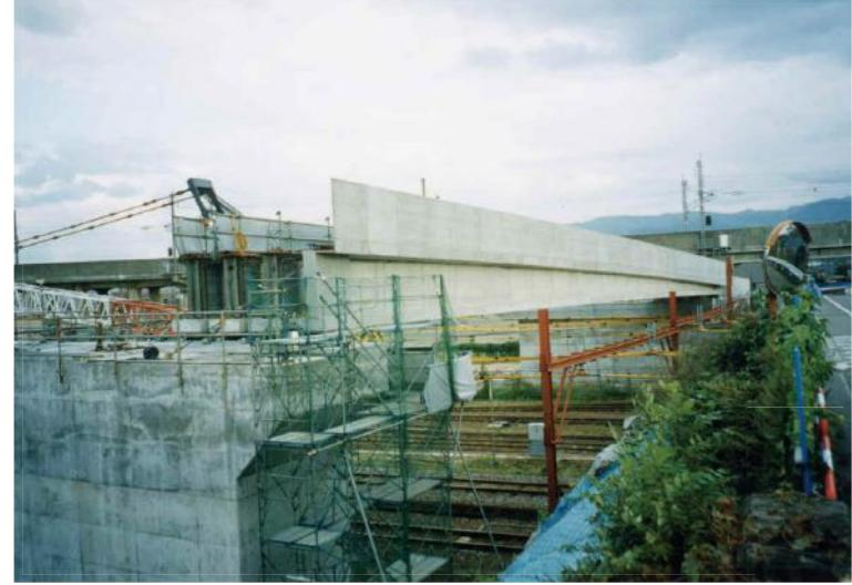
張出し部底型枠・高欄外面型枠設置状況
