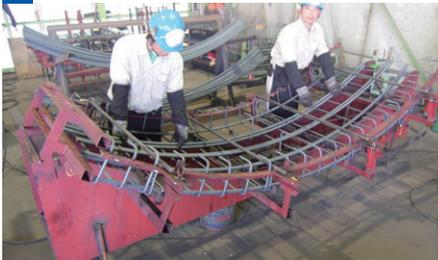
2 型枠組立、鉄筋・金物取付
