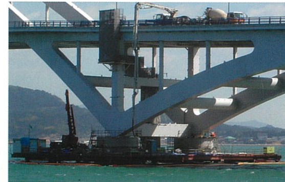
コンクリート充填状況
