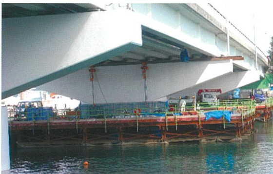
作業構台・ホイストクレーン設置完了
