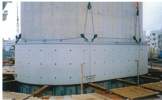
水中へ沈設準備中のパネル
