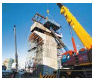
梁部函体建込み
