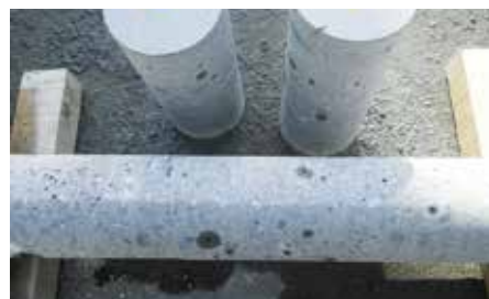
後打ちコンクリートと一体化したSEEDフォームの断面
