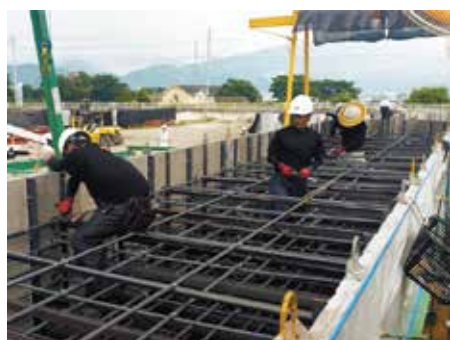
SEEDフォーム函体の製造(工場)
