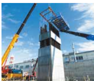
柱部函体建込み
