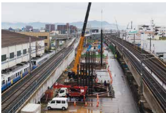
狭隘な施工ヤード
