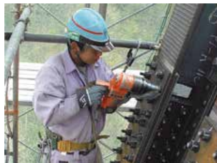
ストライプHの接合状況
